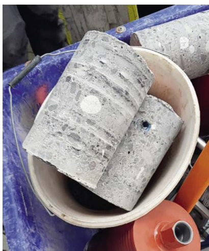
Der herausgebohrte Betonzylinder zeigt eindrücklich die Dicke der Betondecke.
