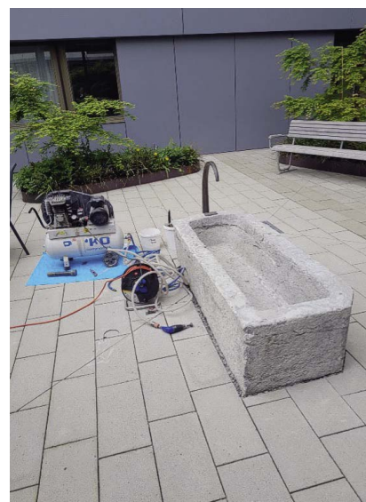
Der Brunnentrog wird abgedichtet.
