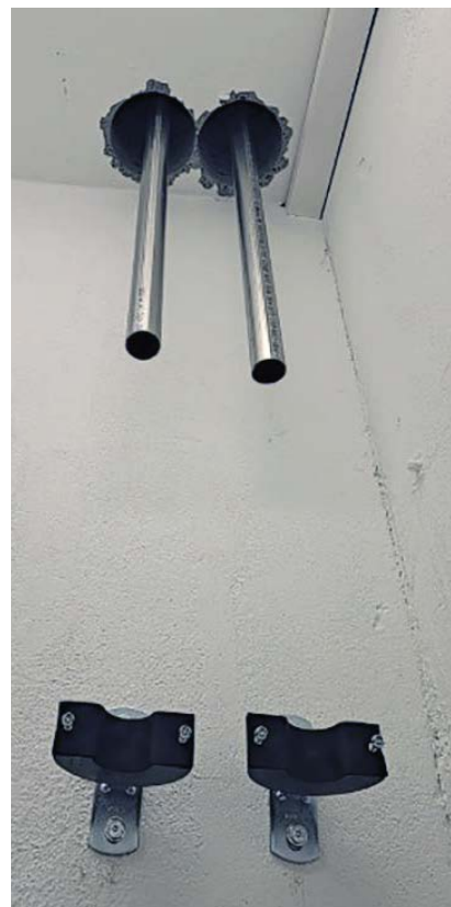
In die ausgebohrten Kanäle werden die Kälteleitungen eingelegt.
