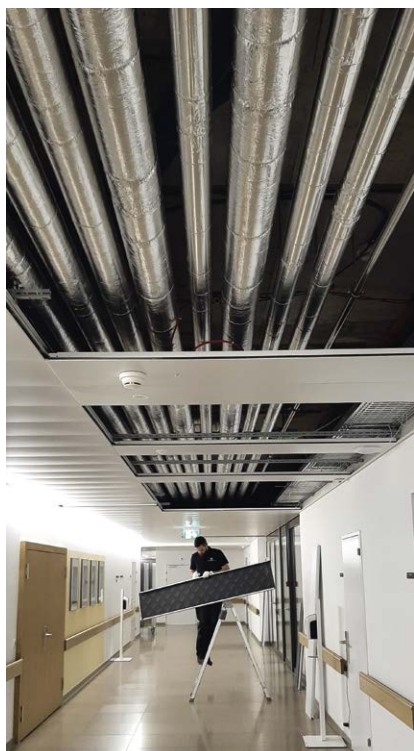
Offene Decke im Untergeschoss des Alterszentrums Acherhof.
